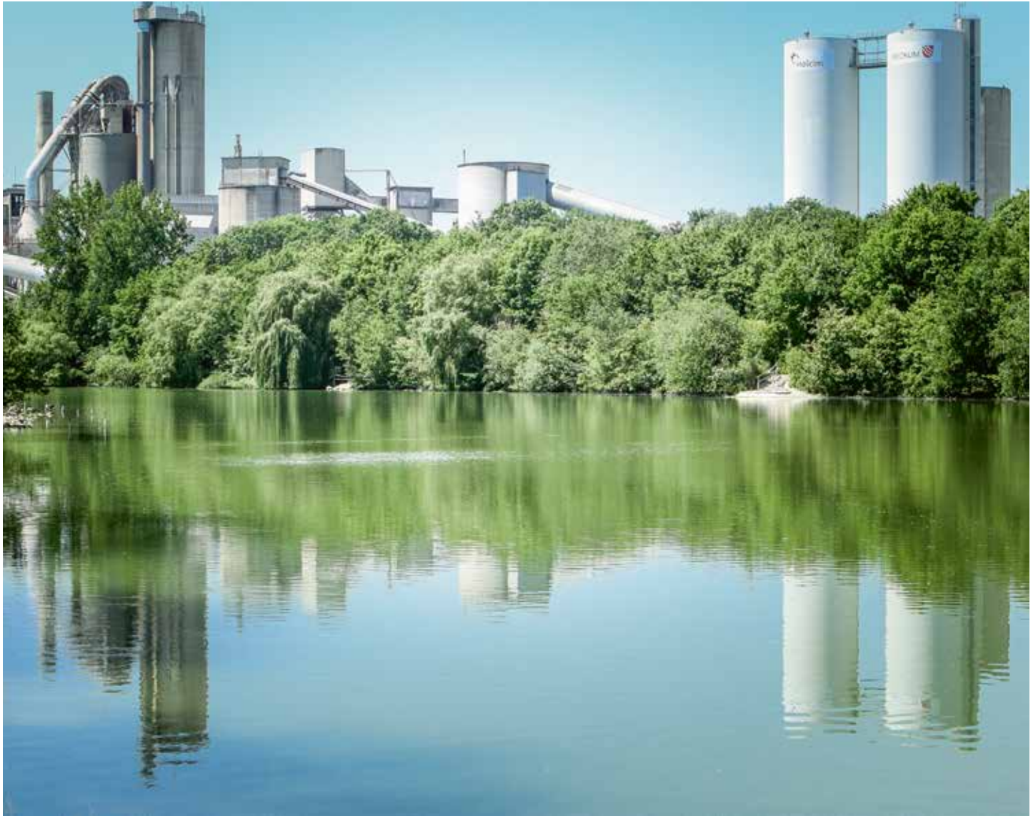
Auch die heute nicht mit vernünftigen Aufwand vermeidbaren Emissionen müssen neutralisiert werden: Zementwerk Beckum.
